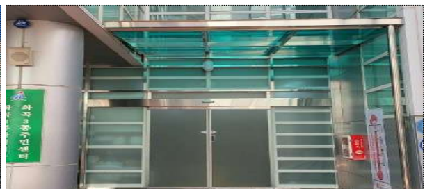
입구(자동문 설치, 자전거보관소 교체)
