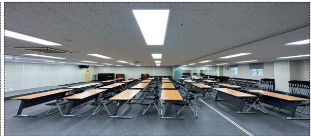
다목적홀(조명·바닥공사, 천장도색, 천갈이)
