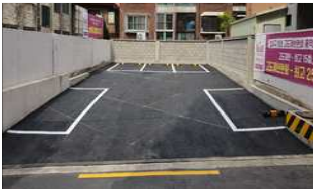
주택가 소규모 주차장 조성(예시)
