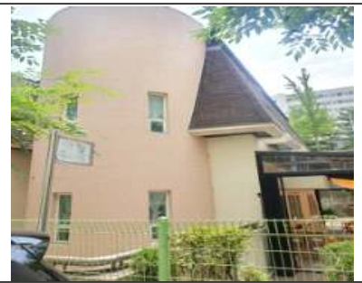
유치원 외벽 보수
